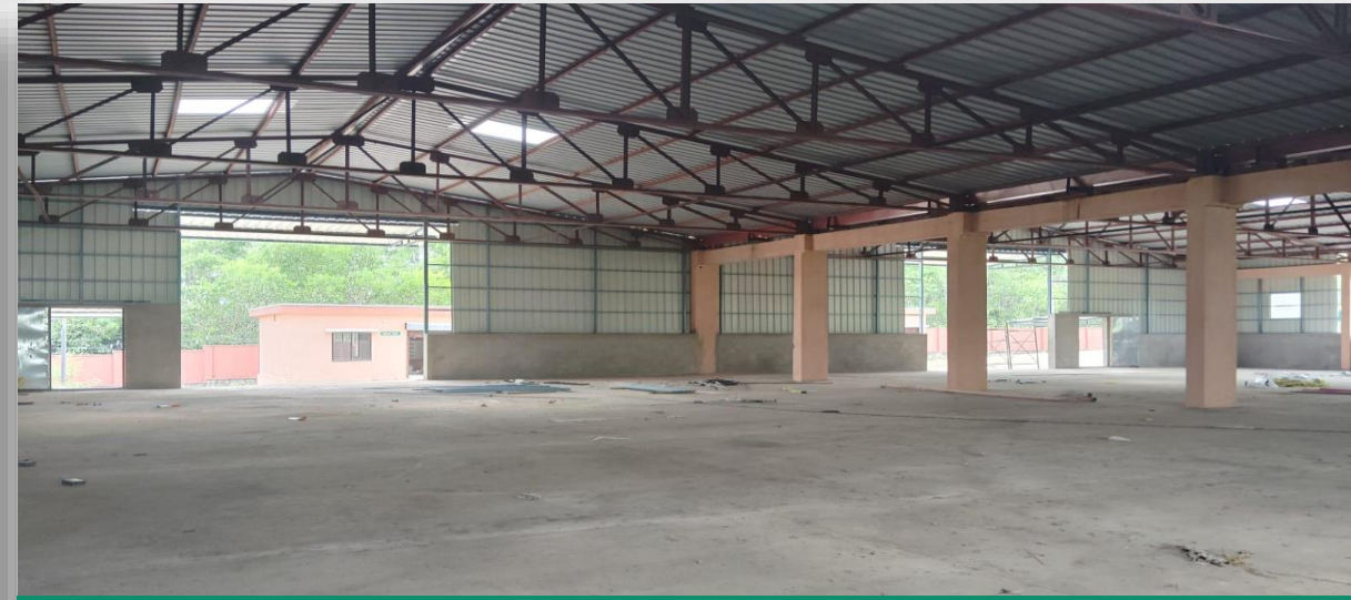
MRF Shed in Kaup, Udupi Dt.
